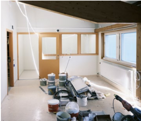
Lokalerna har tidigare varit klassrum för de vuxna på anstalten men de målas och renoveras nu för att ta emot de unga.
